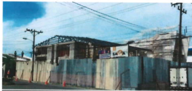
ESTADO Ejecución de la construcción con un avance del 35,11% según la metodología Cartería del Pre-2.
